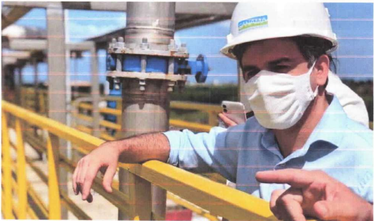
Vereador Joãozinho e Comissão Especial de acompanhamento as obras visitam estações da Sanama - Foto: Assessoria
