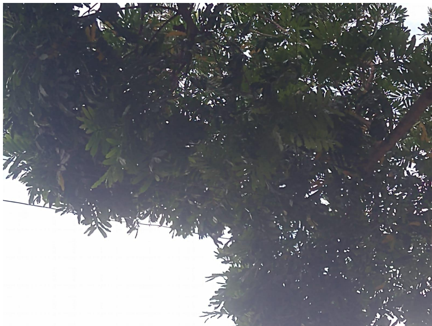
FIOS COMPROMETIDOS COM ARVORÉ 1
