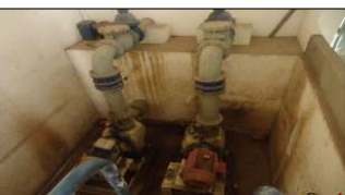
Figuras 130 e 131. Vista dos GMBs e quadro de comando EEE – Joaquim Leão.Fonte: MJ Engenharia
