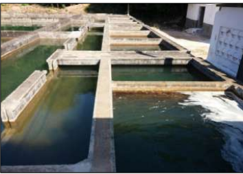
Figura 61. Tanques de coagulação e floculação. Fonte: MJ Engenharia.
