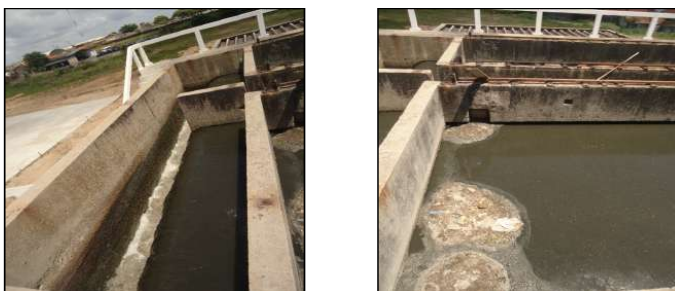
Figuras 85 e 86. Detalhes da Caixa de Areia em funcionamento. Fonte: MJ Engenharia
