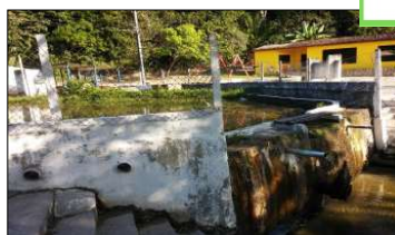
Figura 55. Barragem do Riacho Aviação. Fonte: MJ Engenharia
