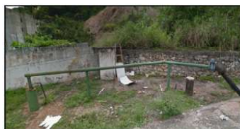
Figura 49. Poço de captação da CASAL
