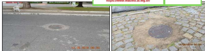
Figuras 92 e 93. Poços de visita da rede coletora existente nos bairros Jaraguá e Pajuçara, respectivamente. Fonte: MJ Engenharia
