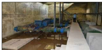
Figura 52. Bombas da Estação de Bombeamento de Água Bruta. Fonte: MJ Engenharia.
