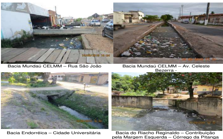
Figura 172: Presença de Resíduos Sólidos e esgotos sanitários na rede de drenagem. Fonte: Autor, setembro/2015.
