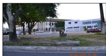
Figura 41. Poço de captação da CASAL
