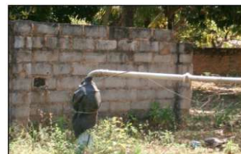
Figura 46. Poço de captação da CASAL
