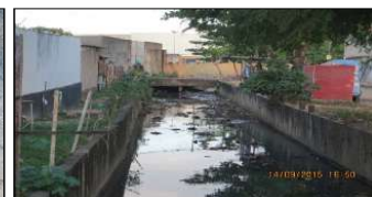
Figuras 138 e 139. Esgoto presente na rede pluvial do bairro Ponta Grossa e riacho comprometido pela poluição no bairro Vergel do Lago.Fonte: MJ Engenharia
