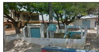
Figura 50. Poço de captação da CASAL
