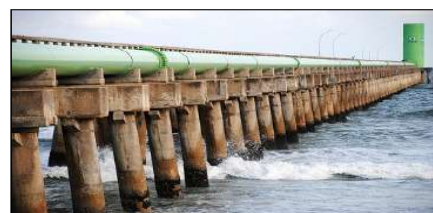
Figura 89. Emissário Submarino de Maceió – trecho de tubulação aérea. Fonte: http://www.tribunahoje.com/vgmídia/imagens/48720_ext_arquivo.jpg (acesso em 05/09/2015)
