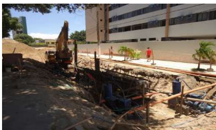
Figura 91. Obras de ampliação da rede coletora de esgotos na bacia Sudeste. Fonte: MJ Engenharia
